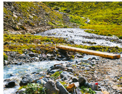
Silvretta: Durch den Felssturz am Fluchthorn mussten Wege verlegt werden.
