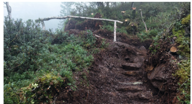
Abbildung 15: primitiver Handlauf im Nichtabsturzgelände gegen Abkürzter (Foto: C. Piccolruaz).
