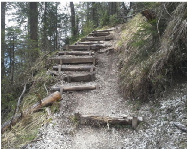
Abbildung 18: Treppe mit nebenliegendem Fahrbereich. (Bild: Amor)
