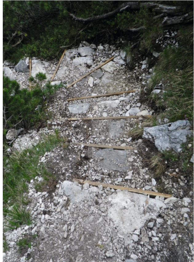
Abbildung 22: Hinterfüllte Stufen mit Steinen und Schotter. (Bild: Amor)
