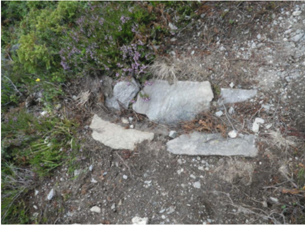
Abbildung 13: Querrinne aus Steinplatten. (Bild: Amor)
