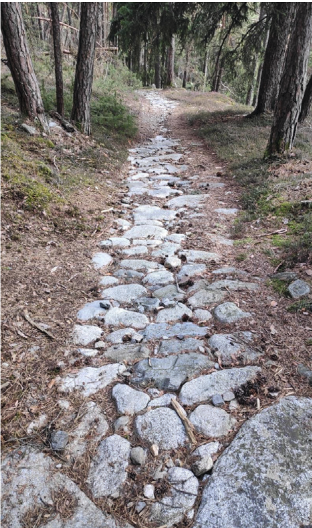
Abbildung 25: Steinarmierung. (Foto: B. Trotter)
