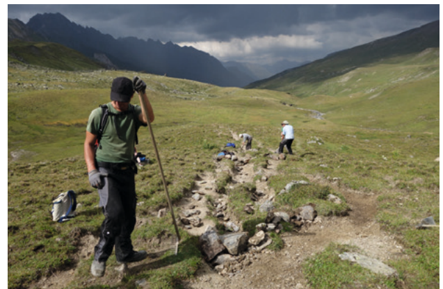
Abbildung 17: Wegführung und Sperren von Abschneidern mit Steinen (Bild: Derungs)
