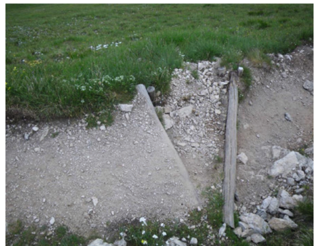
Abbildung 12: Querrinne aus Baumstämmen. (Bild: Amor)
