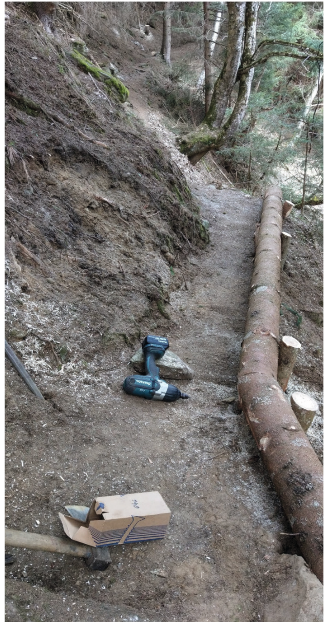
Abbildung 23: Vorbereitete Wegkante aus massiven Baumstämmen d=20\text{cm} , vor der Verfüllung. (Foto: C. Piccolruaz)
