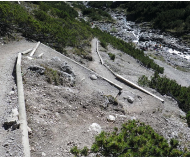
Abbildung 24: Wegkantenstabilisierung. (Bild: Amor)
