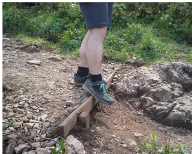
Abbildung 19: Kantige Stufe für Wanderer gut, bei MTB Benutzung wirkt eine große Kraft! (Bild: Amor)
