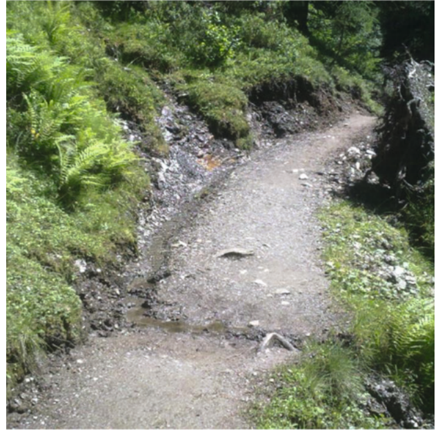
Abbildung 4: Hangwasseraustritt mit Entwässerungsrinne (Bild: Amor)
