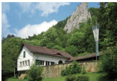
Ebinger Haus (DAV) am Stuhlfels
