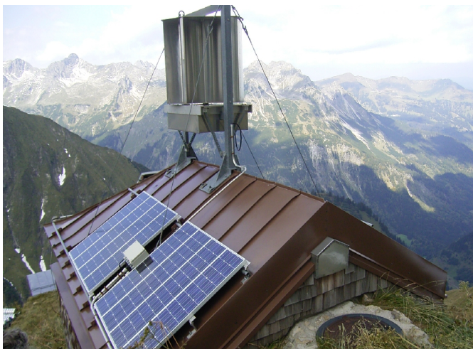
Abbildung 31: Windkraftanlage auf Hüttdach
