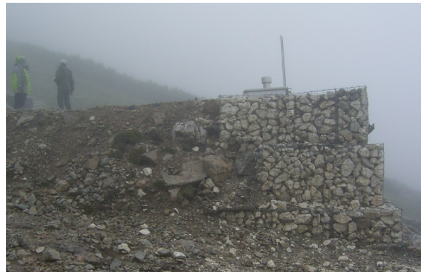
Abbildung 82: Eingesteinter Edelstahl-Hochbehälter - Watzmannhaus
