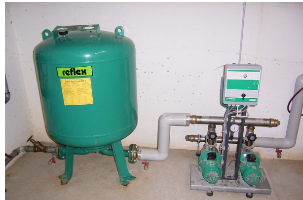
Abbildung 84: Druckerhöhungsanlage Rappenseehütte
