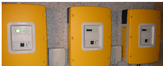
Abbildung 39: bidirektionaler Wechselrichter
