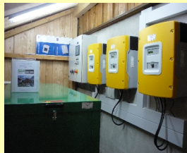
Inselwechselrichter mit BHKW
